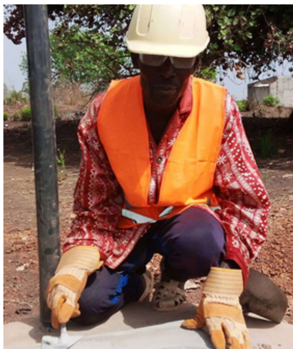
"Un maçon en train de construire une latrine"
