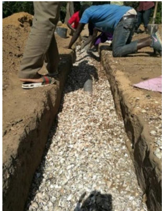
Photo 6: Construction d'un lit de filtration
