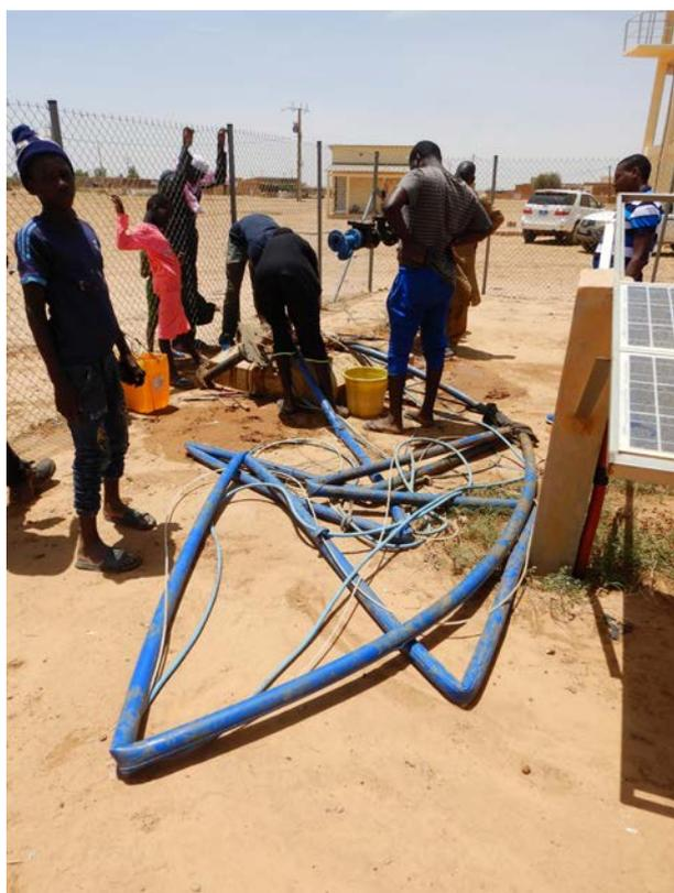
Photo 1: Installation de la nouvelle pompe à Dial, Matam
