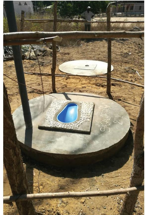
Figure 2: Latrine Ventilée (LV) pour zones à nappe affleurante avec fosse directe étanche, aérée et dispositif SATO pan reliée à un décanteur et un lit d'infiltration
