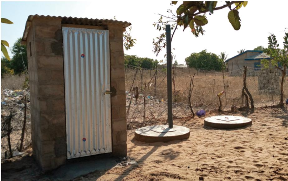
Figure 1: Toilette à Chasse Manuelle (TCM) pour zones à nappe affleurante : possède une cabine reliée à une fosse étanche avec décanteur et lit d'infiltration
