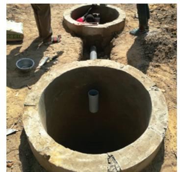
Si la réalisation de tranchées d'infiltration s'avère difficile par une mauvaise tenue des parois (cas des sols sableux), un lit d'épandage à faible profondeur remplace les tranchées. Le sol en place est utilisé comme système épurateur. L'évacuation de l'eau s'effectue par infiltration dans le sous-sol, à la fois en fond de fouille et latéralement.
