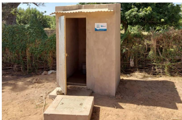
Toilette à Chasse Manuelle (TCM) installée par SBG à Kaolack.
