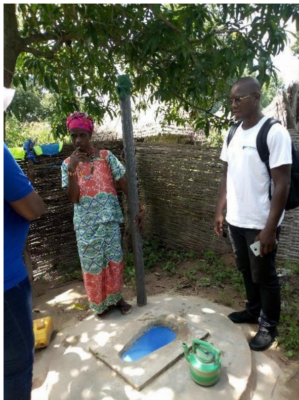
Visite d'une latrine dans la commune de Bignarabé, région de Kolda
