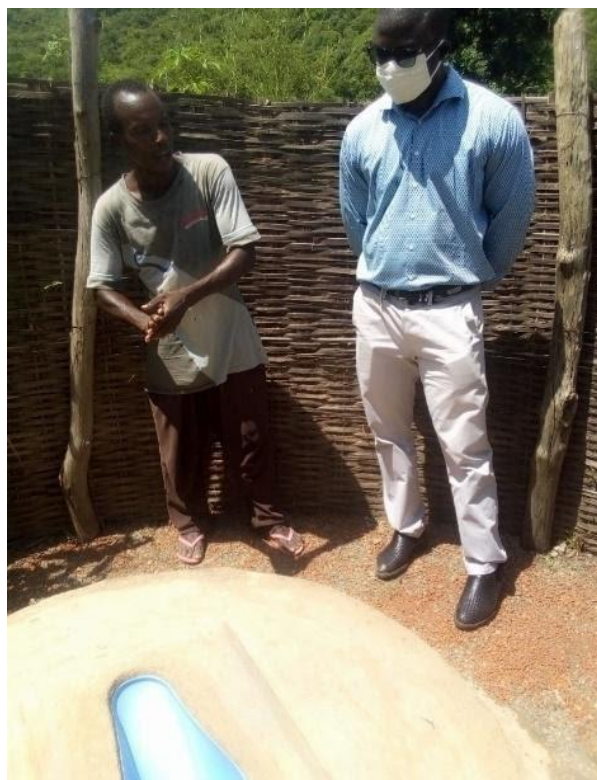
Visite d'une latrine dans la commune de Bignarabé, région de Kolda
